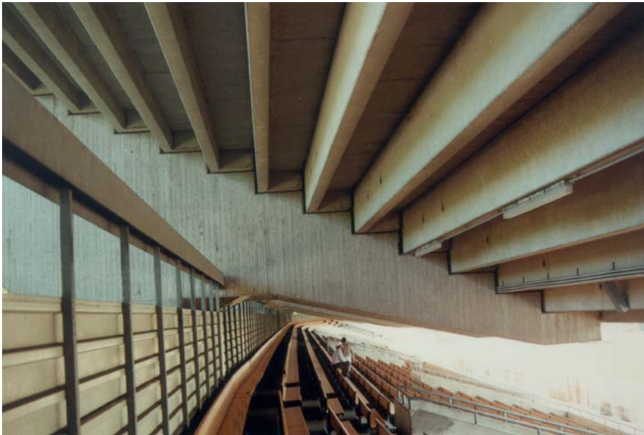
Bild 7: Untersicht der Tribünenstufen und Kragarm des Tribünenbinders
