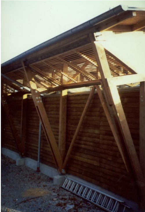
Bild 21: links: Rundholz unterhalb Dachrinne als "Fangseil" beim Schloss Roseck, Tübingen, rechts: Detailansicht Traufknoten (liegender Rahmen)
