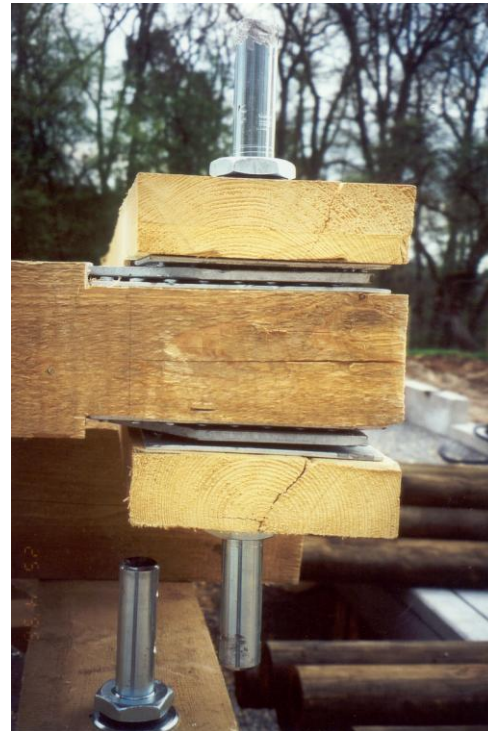
Bild 21: links: Rundholz unterhalb Dachrinne als "Fangseil" beim Schloss Roseck, Tübingen, rechts: Detailansicht Traufknoten (liegender Rahmen)
